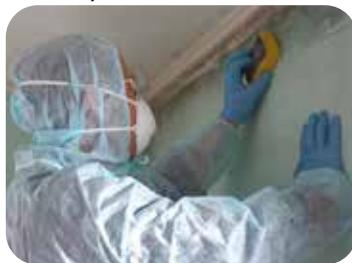
Commencer par enlever le plus possible de la moisissure avec un aspirateur à filtre HEPA, puis avec une éponge ou un chiffon propre humidifié avec de l'alcool dénaturé. Bien laisser sécher. Nettoyer le mur ou la surface contaminée par la moisissure avec une solution au savon noir. Rincer abondamment et sécher.
